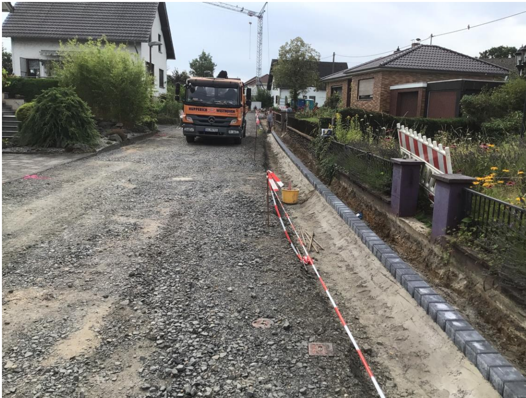
Verlegung Randbefestigung
