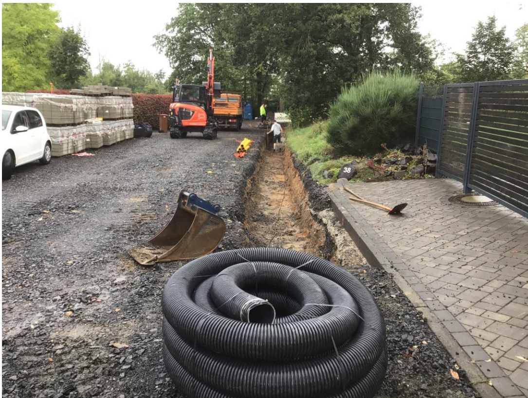
Restarbeiten Verlegung Versorgungsleitungen
