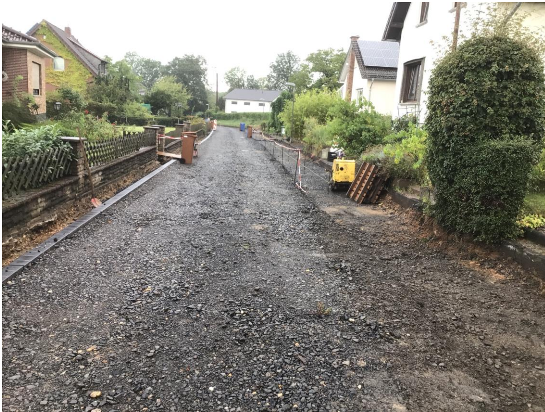
Absteckungsarbeiten Einfassung Fahrbahn
