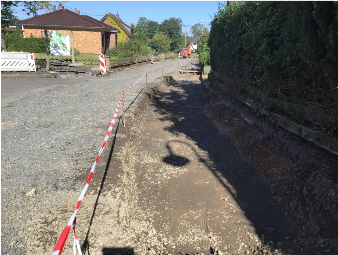
Auskofferungsarbeiten Kreuzung "Grabenstraße"
