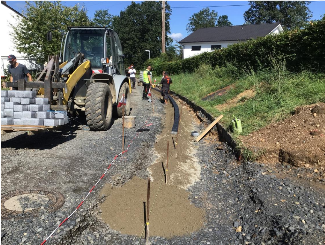
Verlegung Pflasterstreifen Randeinfassung Fahrbahn
