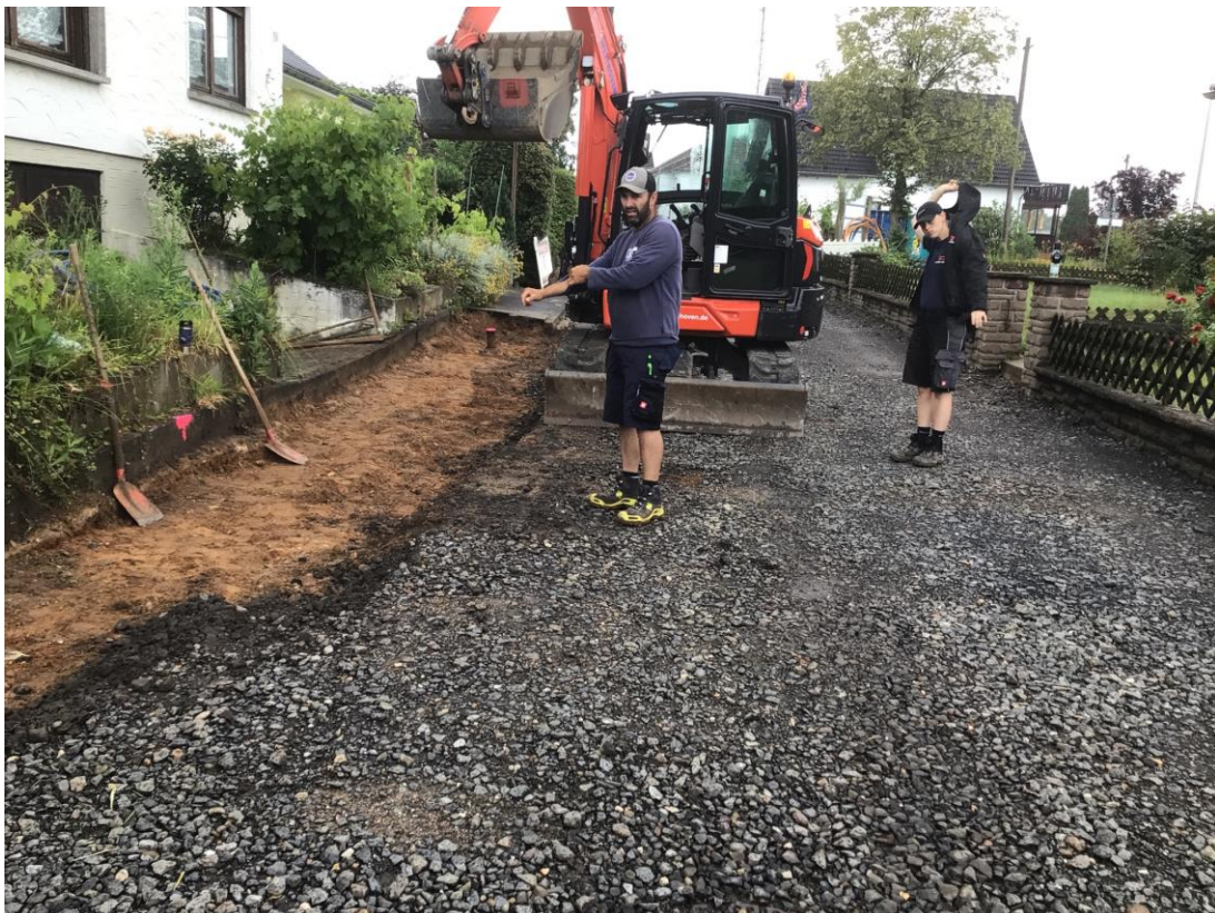
Graben für Gas-/ Wasserhauptleitung und Telekom
