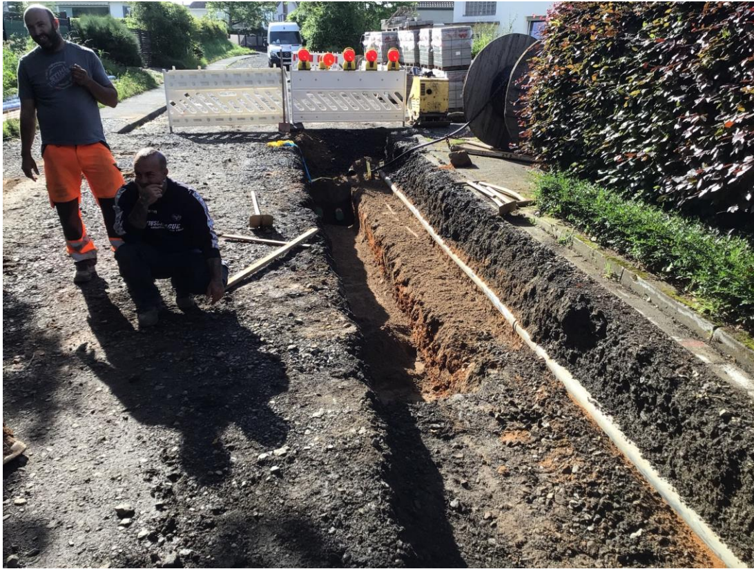
Graben für Gas-/ Wasserhauptleitung und Telekom
