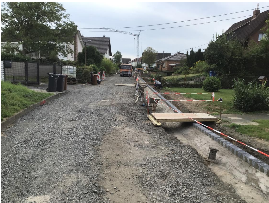
Verlegung Randbefestigung
